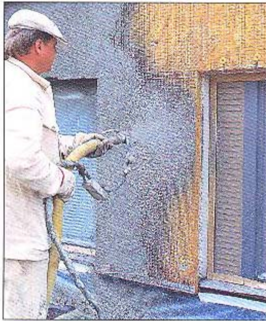
ნახ. 74. კედლის დათბუნება შესაძლებელია განხორციელდეს საფრქვევით თბოსაიზოლაციო მასალის დატანით.
