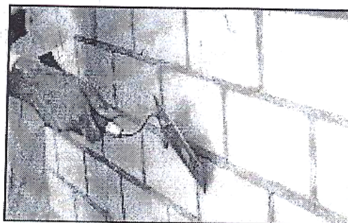
ნახ. 8. აგურის ზედაპირის ნაკერებიდან ზედმეტი ნარევის მოჭრა.
